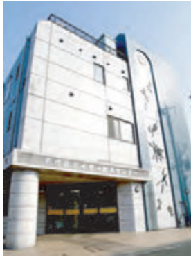
鉄筋コンクリート4階建て
